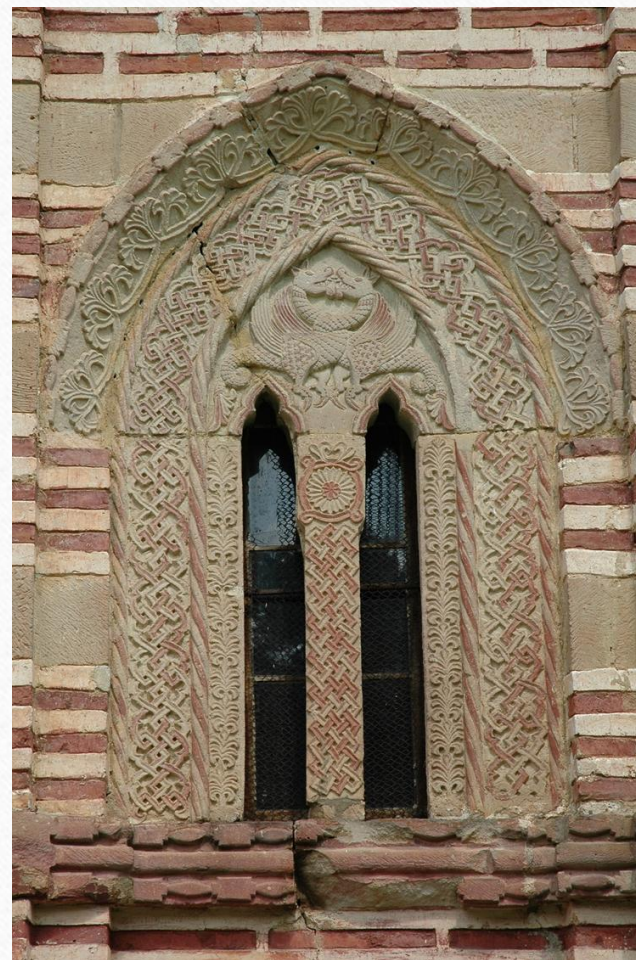
бифора на јужној фасади Каленића
