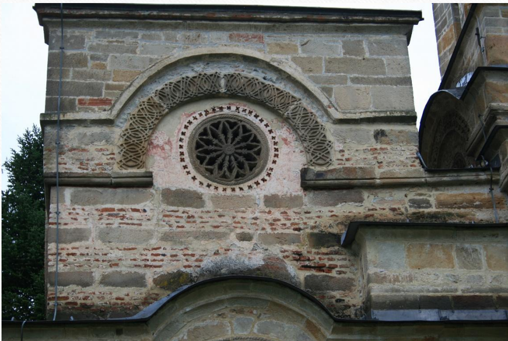
розета на јужној фасади припрате Наупаре
