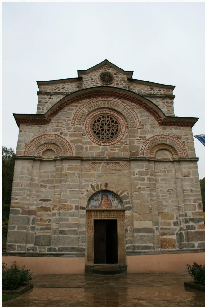
западна фасада Љубостиње
