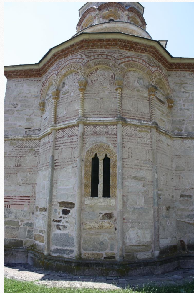
источна фасада Љубостиње
