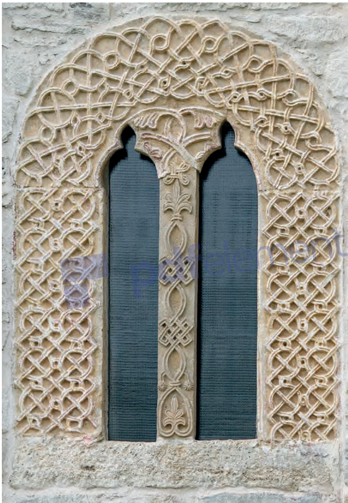
Сл. 360. Манастир Љубостиња, католикон, бифора на јужној фасади
