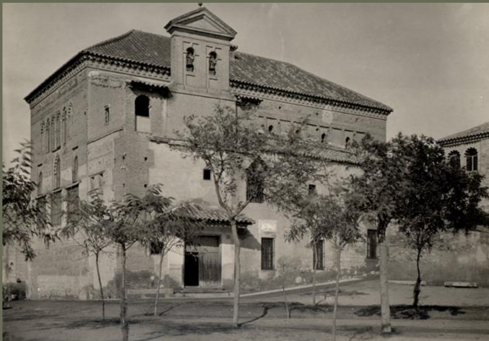
TOLEDO-173-Transito.(Antigua Sinagoga) exterior
