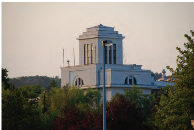
Детаљ западне куле Western tower, detail
