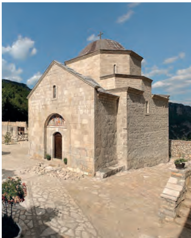
Сл. 330. Соко-град, Црква на Заграђу, изглед цркве са југозапада
