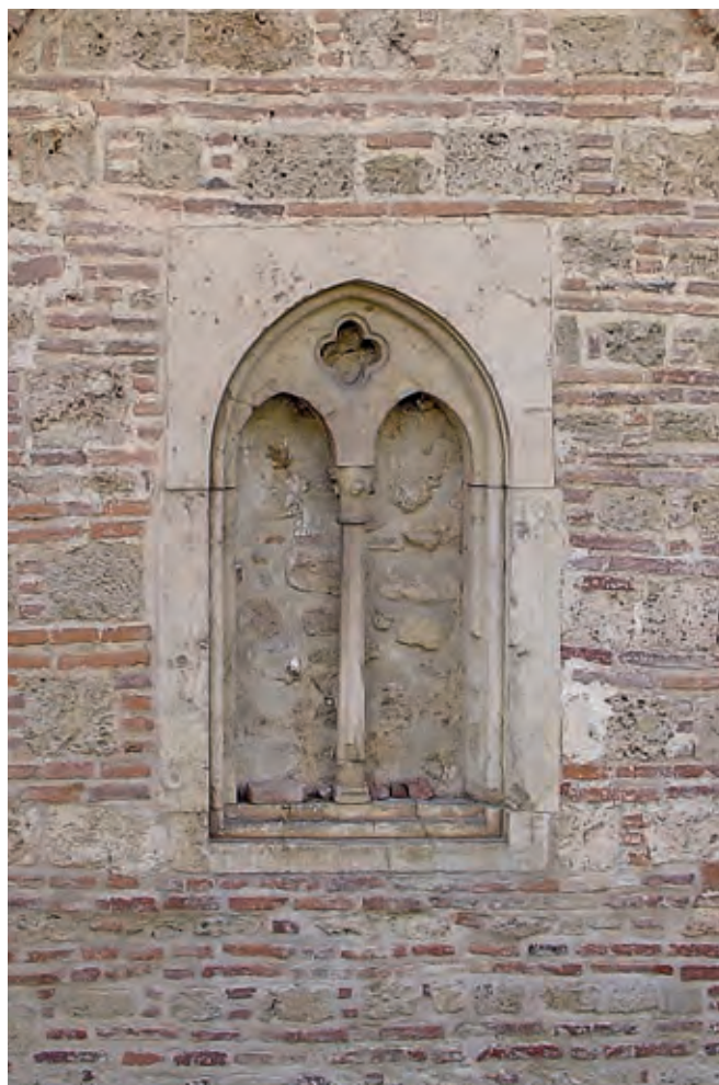
Сл. 217. Пећ, црква Светог Димитрија, бифора на северној фасади
